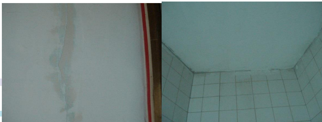
牆壁裂痕泡棉砂紙磨平
