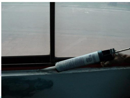
水性矽利康填縫劑填滿拉平
