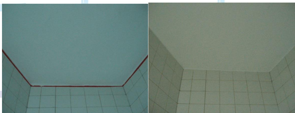
浴室天花板施工(2)
