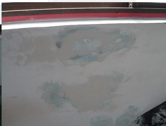
脫落舊漆處，裝潢批土(第二次)
