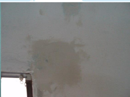
脫落舊漆處，裝潢批土(第二次)
