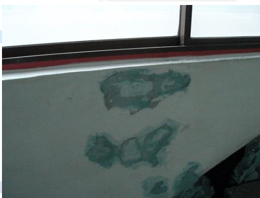
脫落舊漆處，裝潢批土補滿(第一次)
