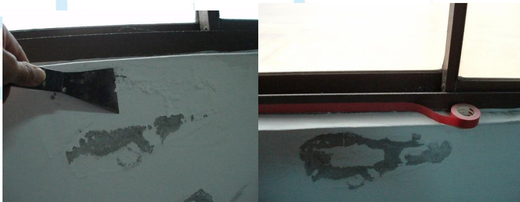
檢驗刀清除脫落舊漆
