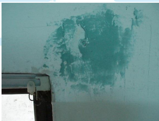
脫落舊漆處，裝潢批土補滿(第一次)
