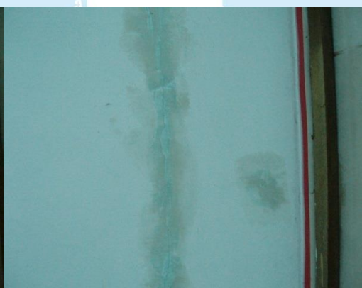
牆壁裂痕裝潢批土補滿(第二次)
