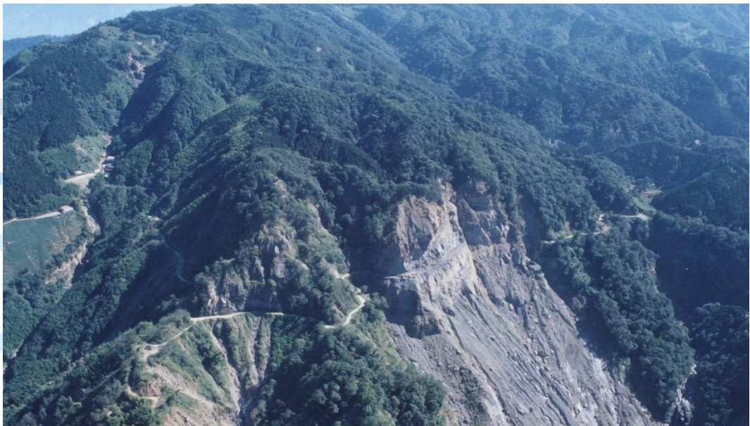
圖二 安定彎震後空照圖
