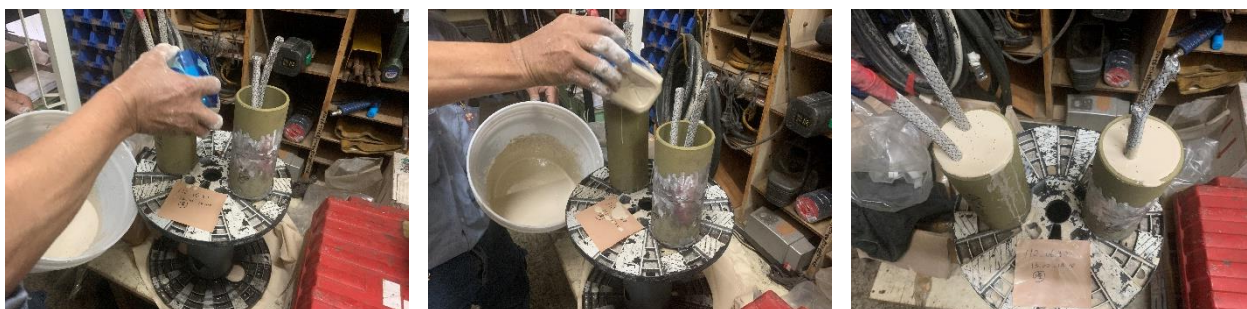
圖 2-3 Sealing Compound 澆灌作業
