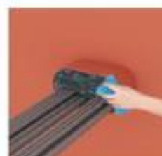
步骤⑤： 用湿毛巾等工具将密封胶抹平并 适度挤压，以保证密封胶和电缆 以及框架的粘结力。
