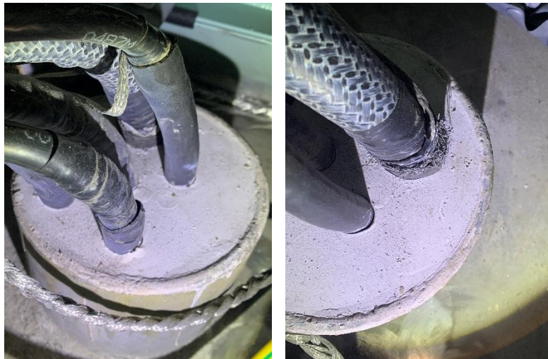
圖 3-2 包覆熱縮套管重新澆灌後之情形
