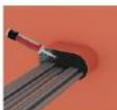
步骤④： 将HK-M膨胀防火密封胶均匀 涂抹于护套的两端，厚度不 小于20mm。
