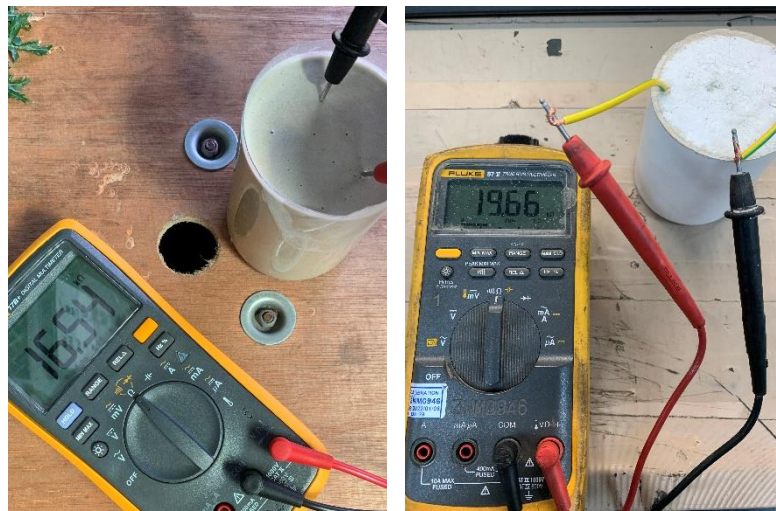
圖 2-11 Sealing Compound 電阻測量
