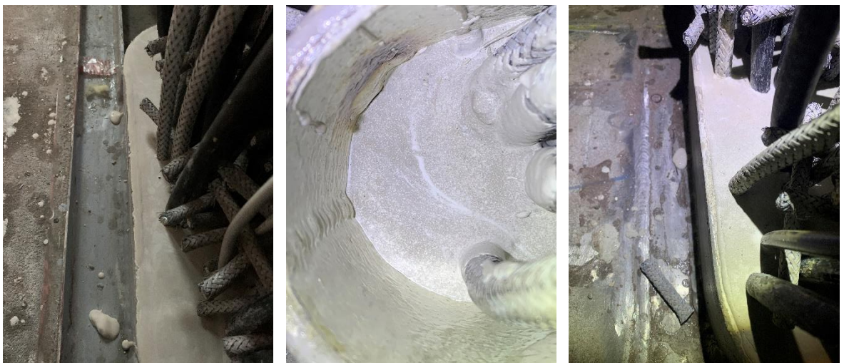
圖 3-7 其餘 3 個貫穿件情況，其中 L4-WT4 貫穿件僅填灌一半
