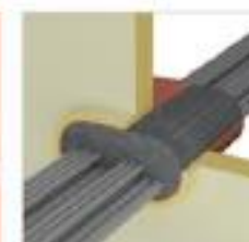
步骤⑥： 在密封胶完全固化前尽量不要扰动 电缆，以保证密封胶的粘结性能。
