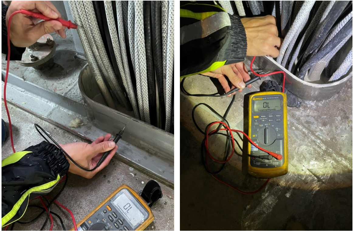
圖 3-6 澆灌打底後電阻值量測
