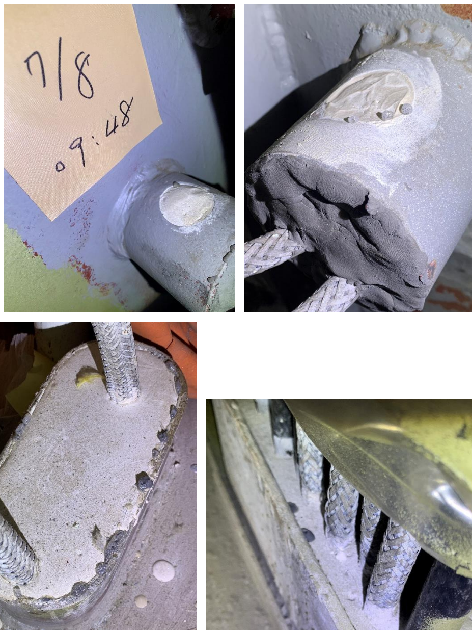
圖 2-9 基隆廠 Sealing Compound 澆灌後情況
