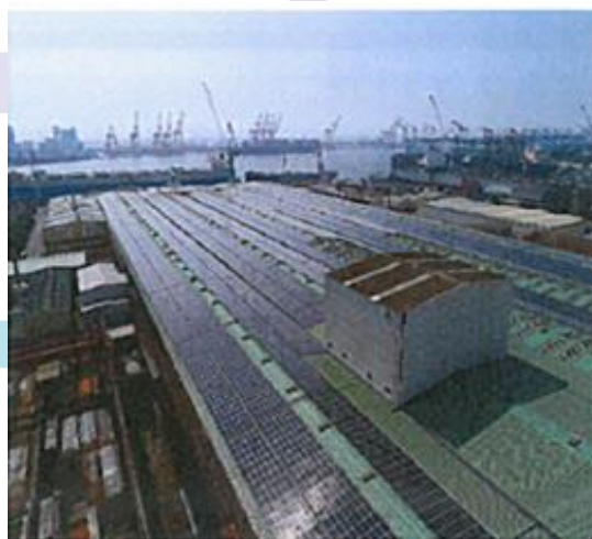
圖二 船體廠屋頂租賃太陽能板完成照片
