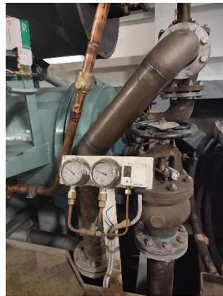
圖 14. 壓力表銅管安裝
