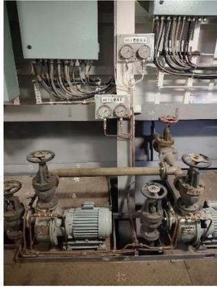
圖 11. 壓力表銅管安裝
