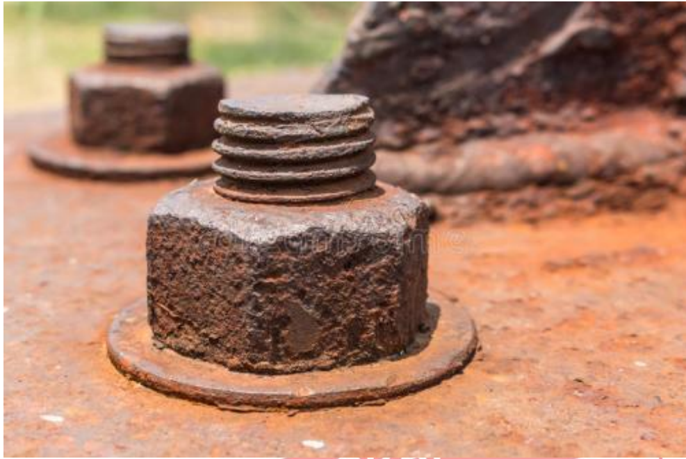
圖 3：裝備螺栓經鹽沉積腐蝕之示意圖
