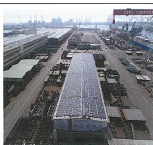
說明:裝配廠完工照
