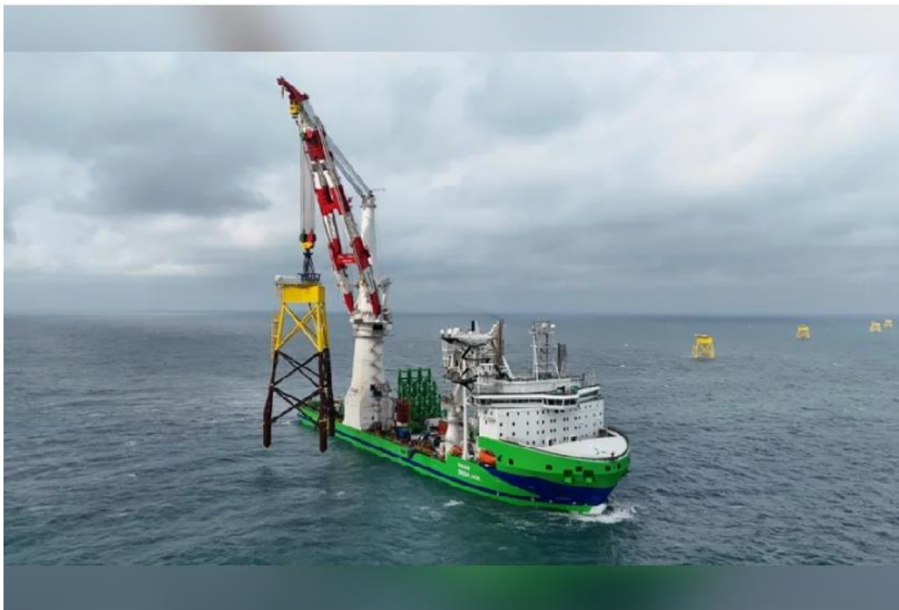
台船環海風電工程公司旗下風電專業工程船「環海翡翠輪」施工情形。照片／台船提供
