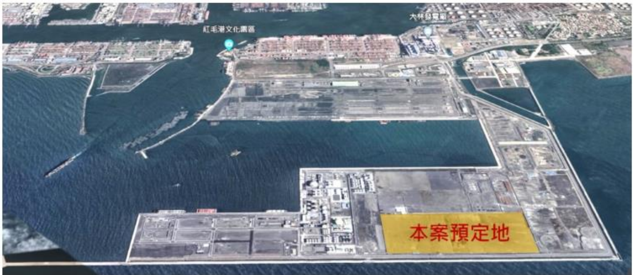
大林石化油品儲運中心槽車裝卸工場統包工程工址。(台船提供)
