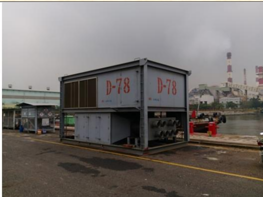
80RT 除溼機外觀，尺寸約寬 3.5 x 長 6.3x 高 3.7M
