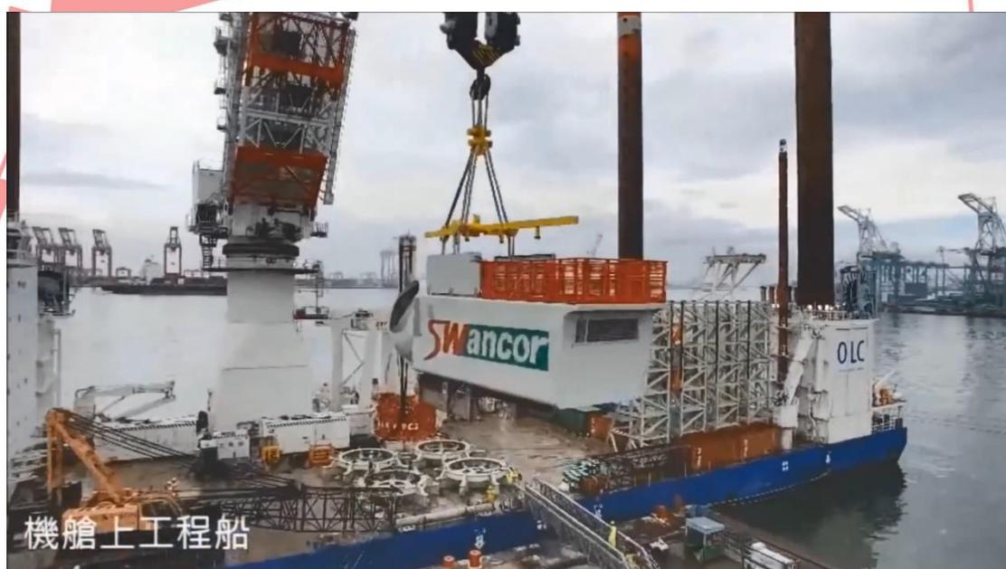
圖五、機艙裝船作業
