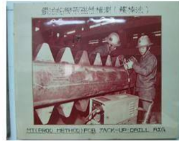
建廠初期鑽油船腳架MT檢查
