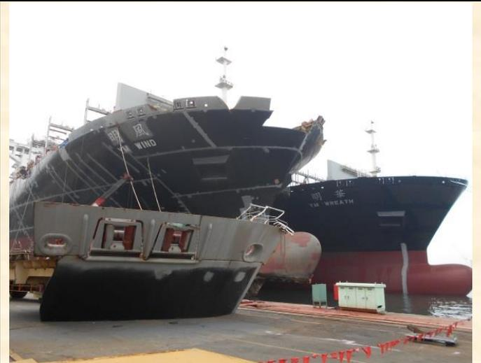
艙甲板分成 4 個 Block 安裝，其施工空間狹窄，搭架搭的密度密麻麻，施工困難度高。
