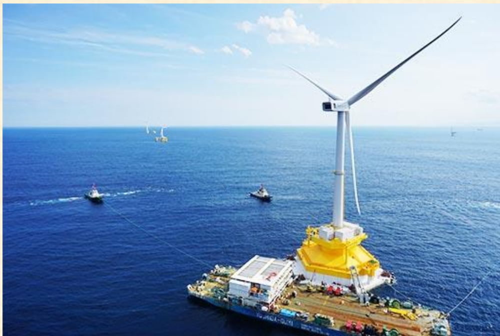
JMU 開發 5MW 浮式風力發電機組，正拖運至日本福島進行發電作業。資料來
