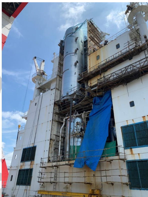
照片 3. 切割機艙艙罩安裝脫硫塔
