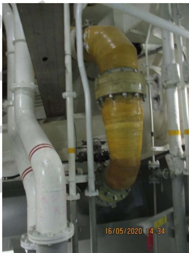
照片 4. GRE 排外管安裝
