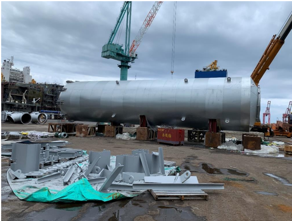
照片 1. 脫硫器主塔及管路、艙品整備
