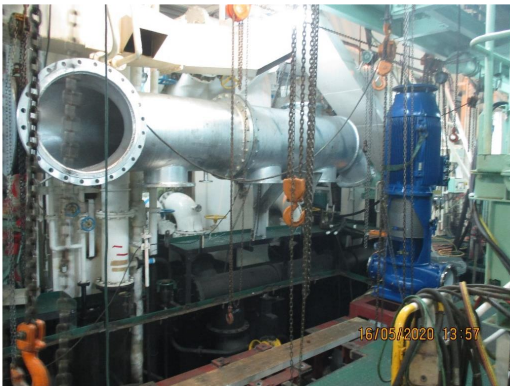
照片 2. 泵及海水管路安裝
