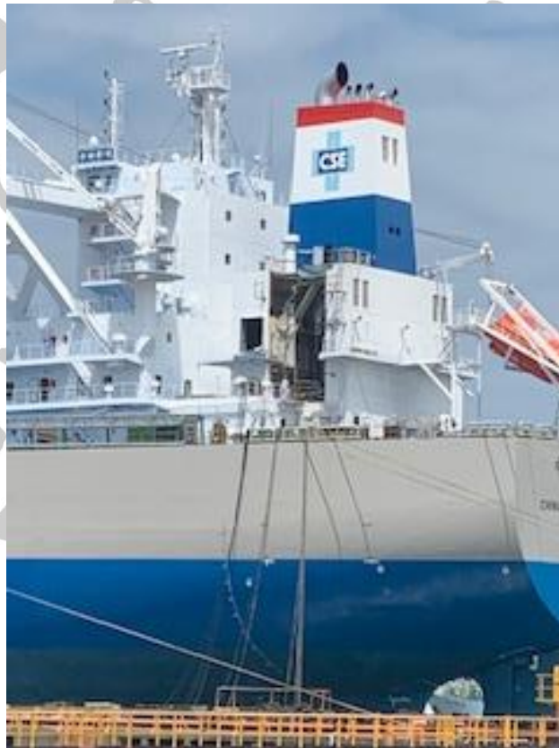
照片 6. 中運 1099s 切割機艙艙罩供吊裝脫硫器
