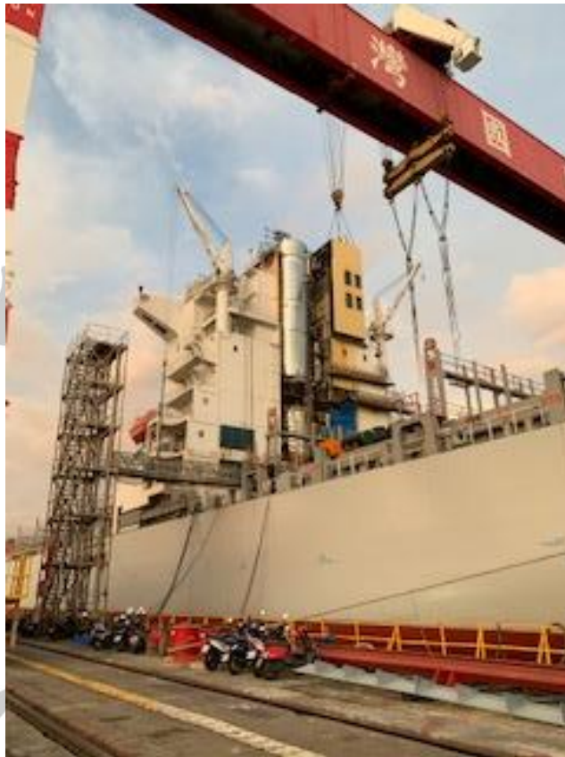
照片 5. 00CL 4500 TEU 脫硫器主塔、副塔吊裝
