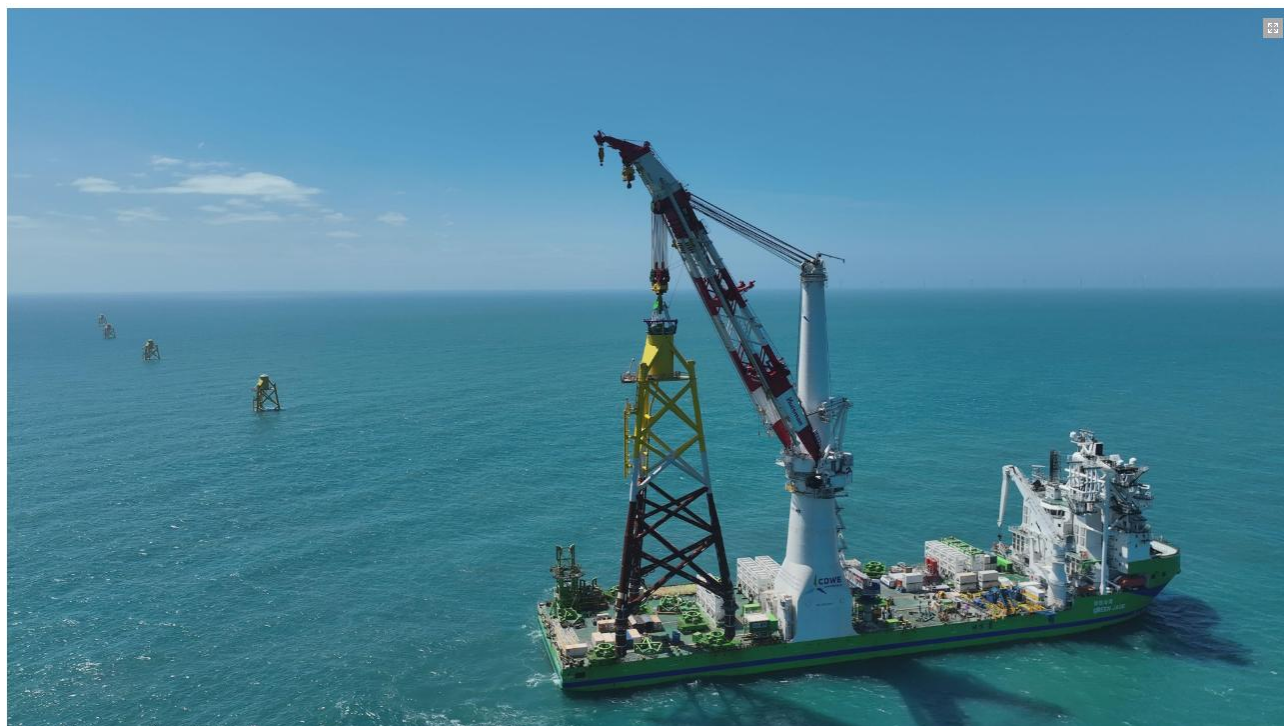
台船環海提前交付海龍計畫套管式水下基礎安裝工程_02
