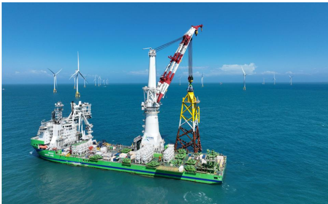
台船環海提前交付海龍計畫套管式水下基礎安裝工程
